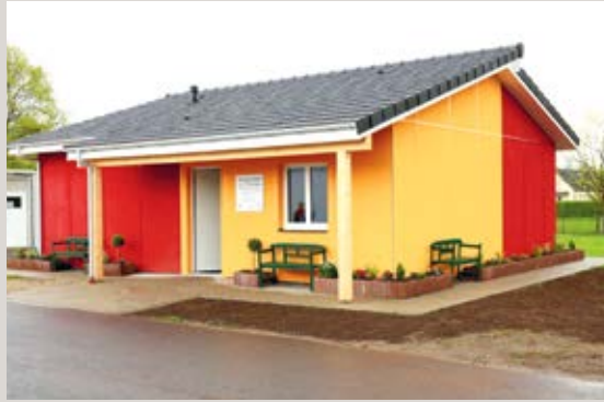
Mit Polyurethan-Hartschaum aus Covestro-Rohstoffen lassen sich günstig Häuser bauen – wie hier in Bergisch Gladbach in Deutschland oder auch in Entwicklungsländern.
